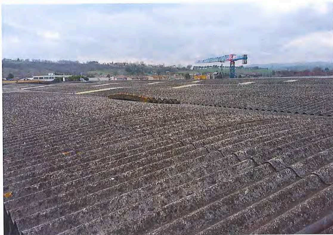
Foto n.4 vista completa della copertura -
