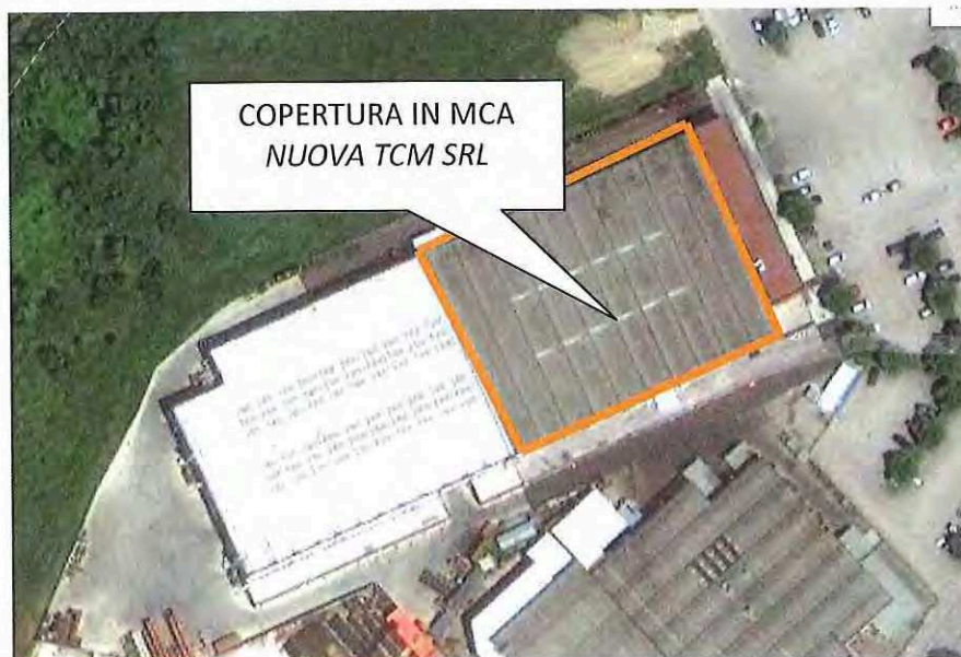
Foto n.1 vista dall'alto della copertura delle 10 arcate della ditta NUOVA TCM SRL
