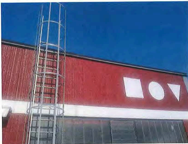
Foto n.2 accesso al tetto mediante scala fissa
